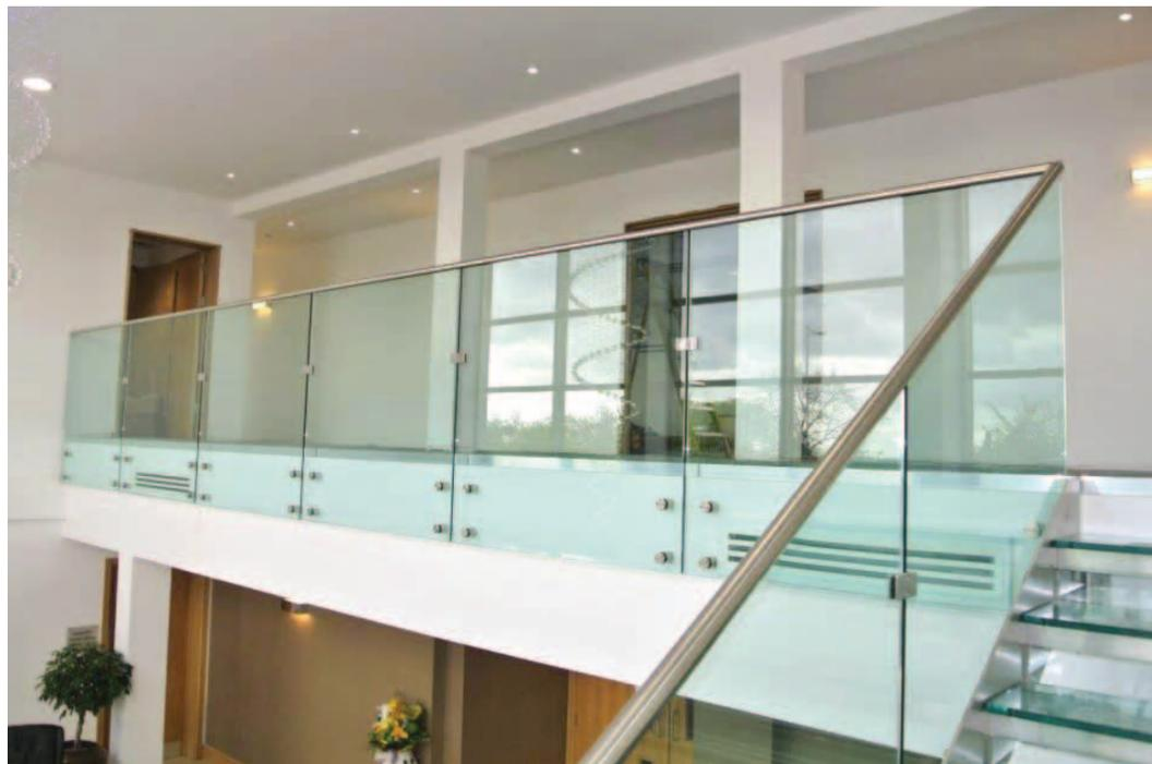
Scala con strutture laterali in acciaio inox sp.mm.10 – gradino in vetro temprato e stratificato – ringhiera in vetro strutturale con corrimano inox – larghezza scala mm. 1400
