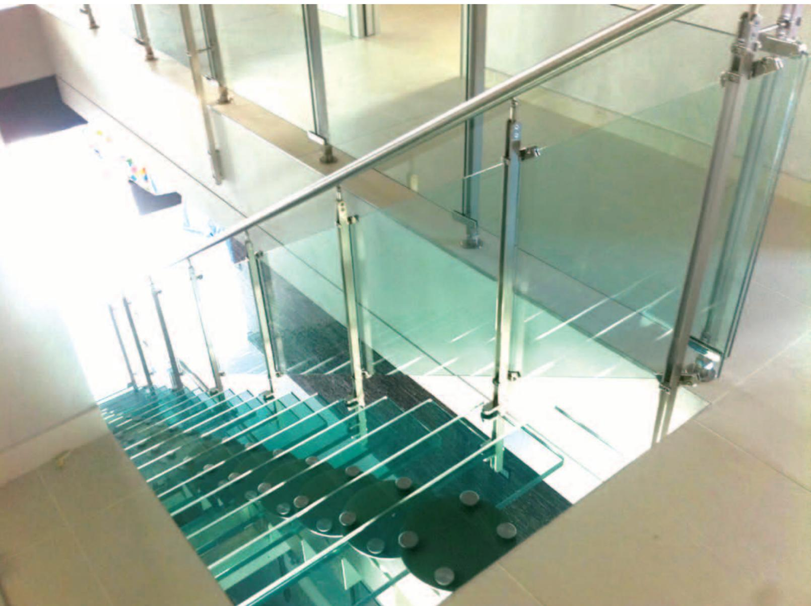
Scala modulare con modulo in acciaio
