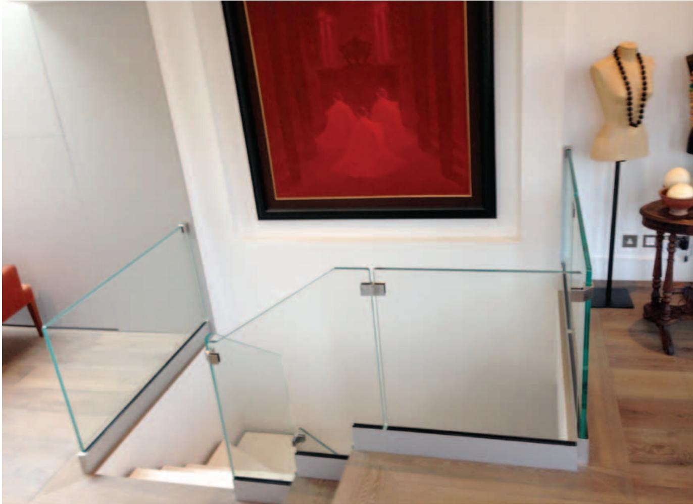
Scala con struttura laterale taglio laser in acciaio inox satinato scala con staffe saldate senza viti a vista sulla struttura – gradino in legno – ringhiera in vetro strutturale 10+10 – scala con protezione alzata in acciaio inox
