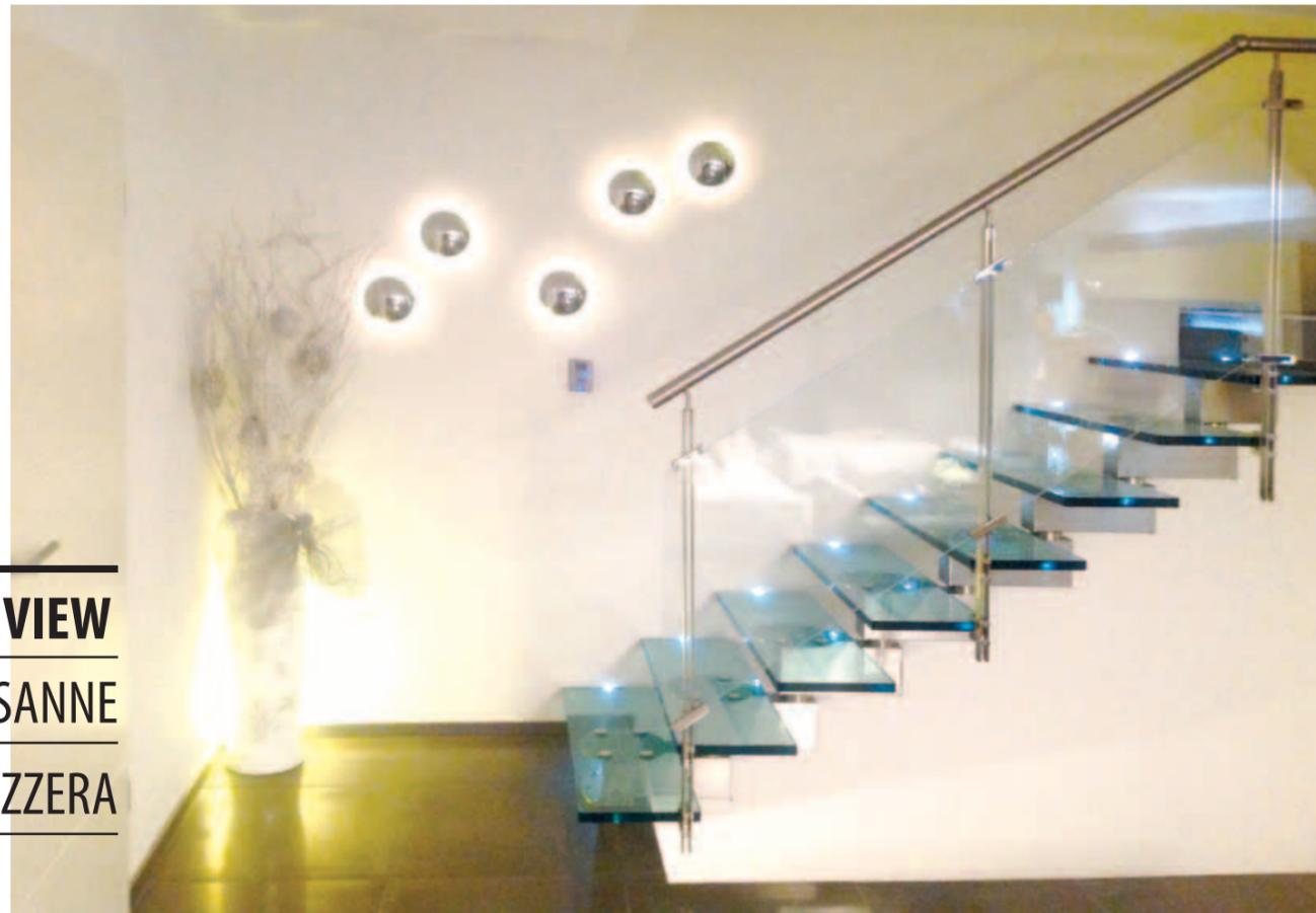
Scala modulare con modulo in acciaio inox satinato. Gradini vetro temprato e stratificato. Ringhiera in acciaio inox satinato
