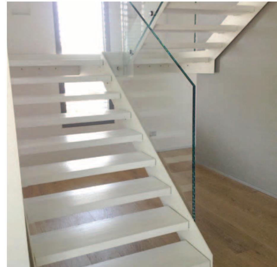
Scala con struttura laterale taglio laser in ferro verniciato – scala con staffe saldate senza viti a vista sulla struttura - gradino in legno rovere – ringhiera in vetro strutturale 10+10
