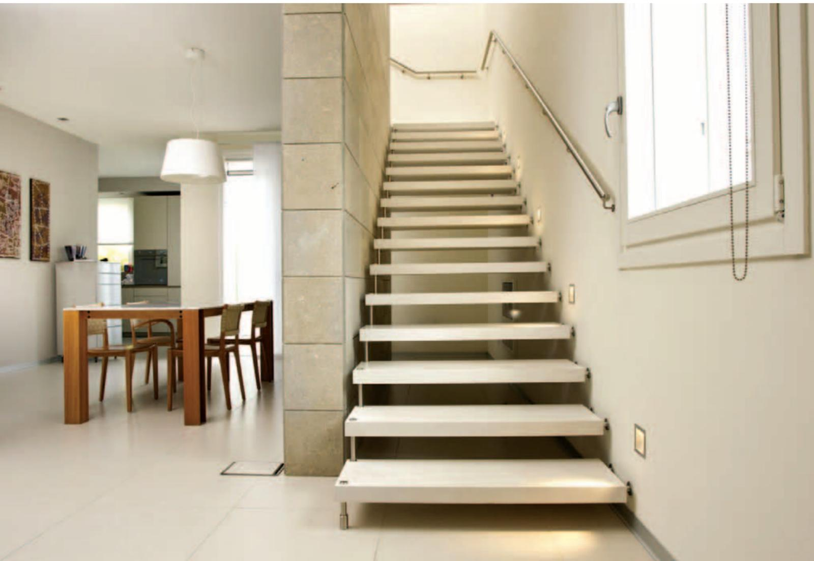
Scala sospesa con gradino in legno spessore mm.60 – scala senza ringhiera con solo corrimano a muro in acciaio inox
